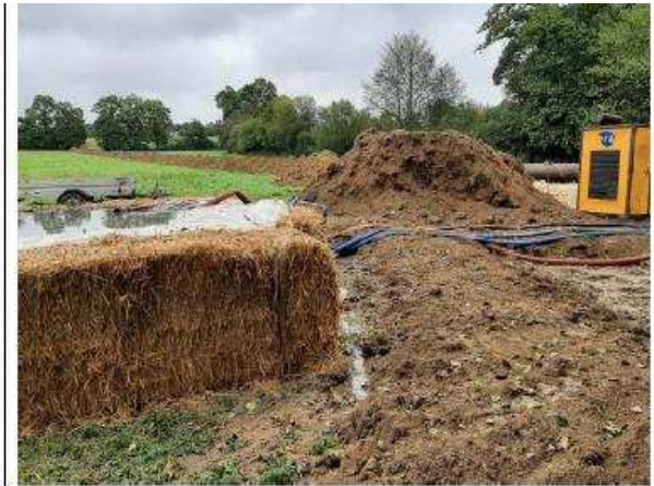
Photo n°3 : Bassin de rétention des eaux de pompage, DLE.
