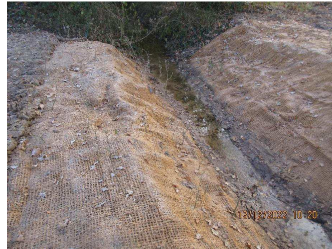
Figure 143 : Remise en état des berges du ruisseau de Roche Cotherel (Bovel)
