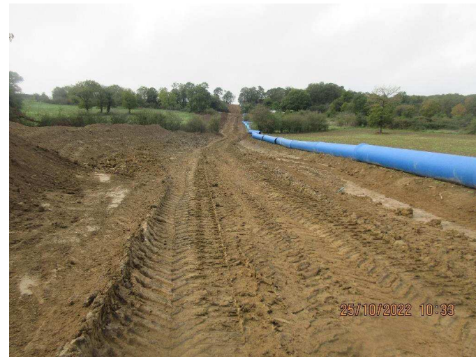
Figure 133 : Stockage des canalisations le long de la piste
