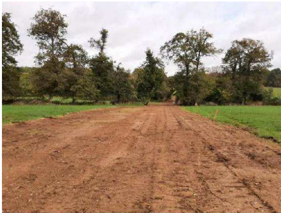
Figure 147 : Restauration d'une zone humide après la pose de la canalisation sur le lot 5
