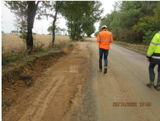
Figure 152 : Pose de la canalisation le long de haies
