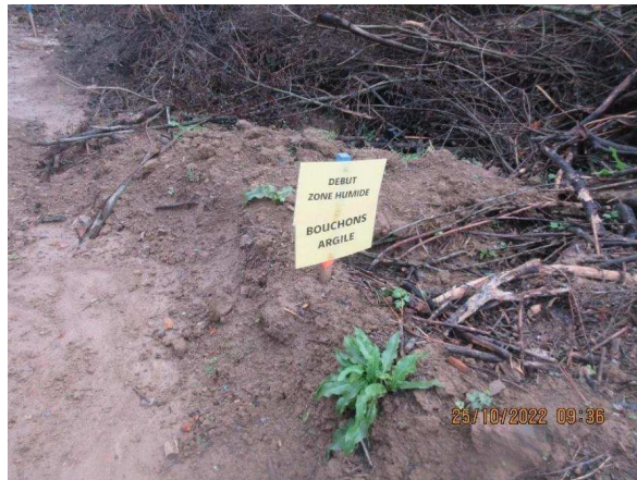
Figure 145 : Piquetage de l'emprise de zone humide et pose de bouchons argileux étanches
