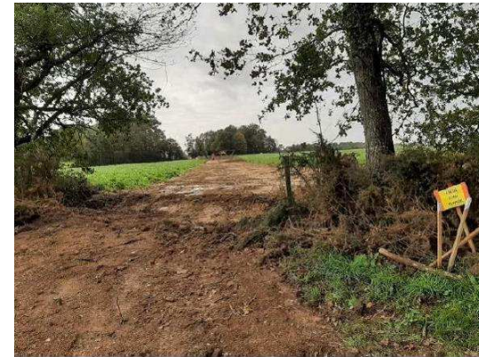
Figure 150 : Franchissement sur talus et fossés qui ont été restaurés au lot 5
