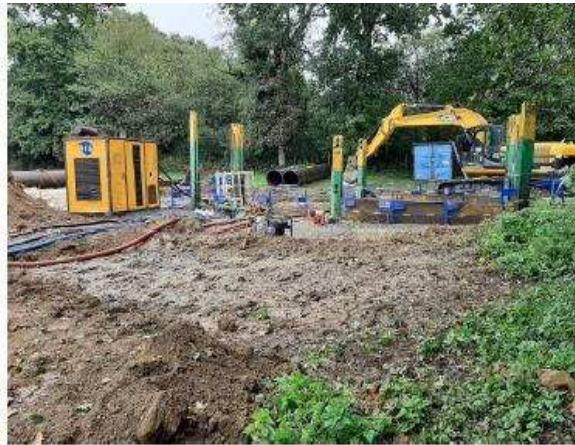
Photo n°2 : Pompage de la fosse, DLE.
