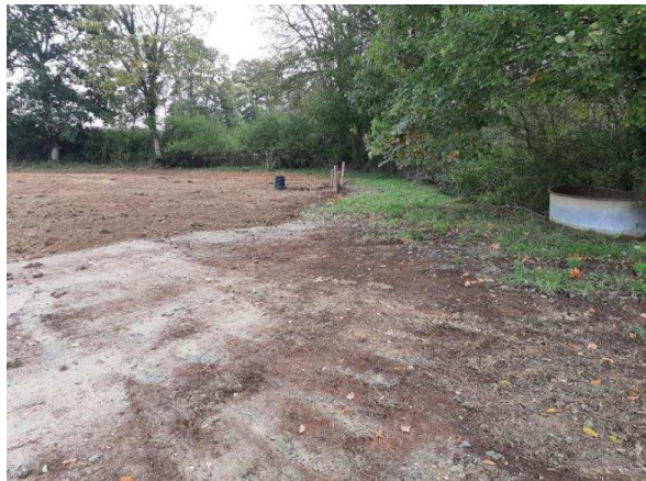
Figure 137 : Remise en état au droit d'une fosse d'entrée de forage du Combs (Saint-Séglin)
