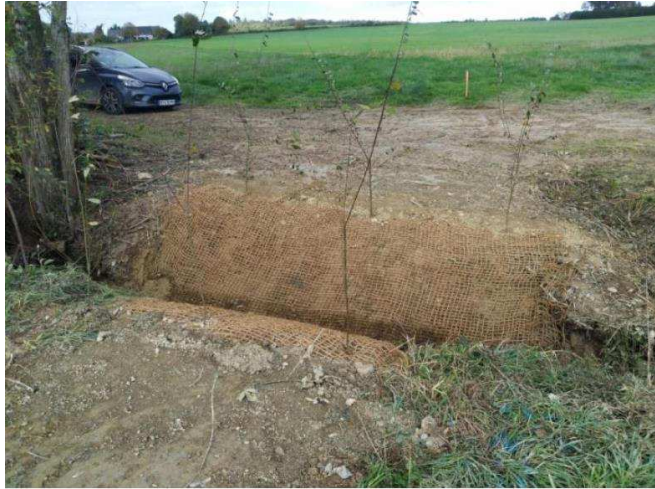
Figure 144 : Remise en état des berges du ruisseau de Joussans (Maure-de-Bretagne)
