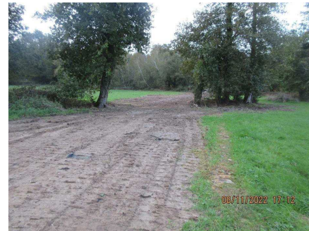
Figure 136 : Remise en état du site
