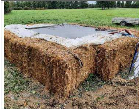
Photo n°4 : Saturation du géotextile du bassin, DLE.
