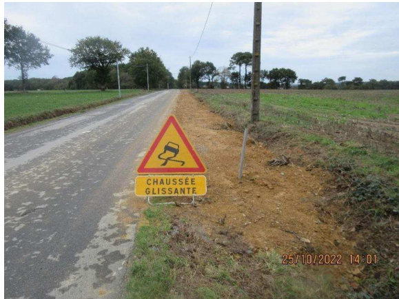
Figure 162 : Signalétique sur le chantier
