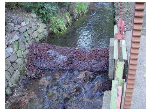
Figure 140 : Exemple de filtre rustique à pouzzolane pour une intervention en rivière de courte durée
