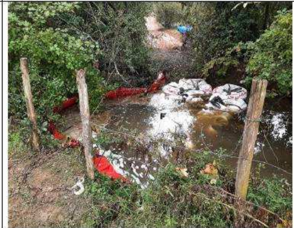
Photo n°6 : Barrage filtrant et big-bags d'argile, le Canut, DLE.
