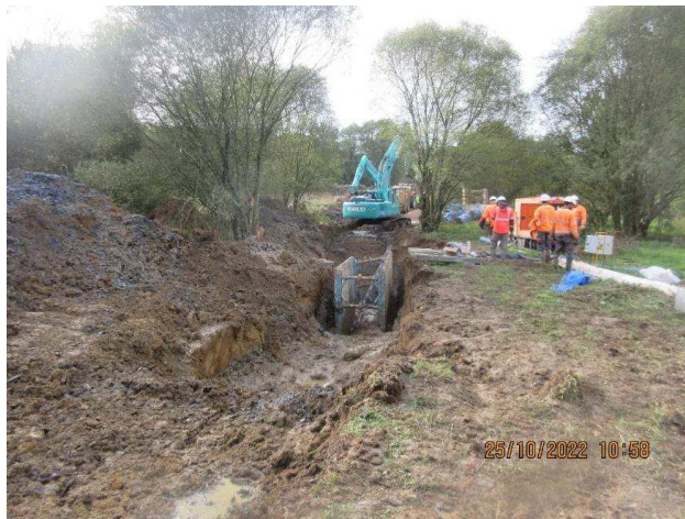
Figure 149 : Traversée de canalisation dans les trouées d'arbres en Tranche 3
